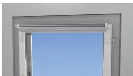
Kameleontti -venttiili valmiiksi asennettuna
