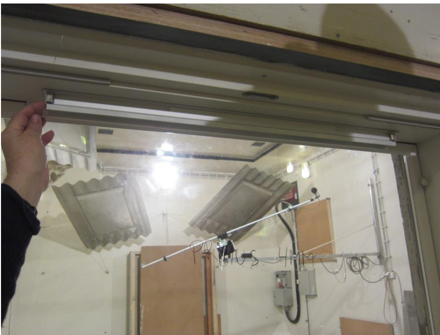
Kuva 4 Suodatinpalkin asennus ikkunaan
