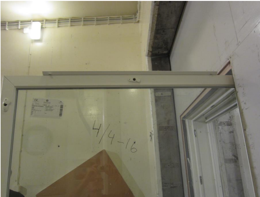
Kuva 3 Venttiili asennettuna ikkunan sisäpuiteeseen
